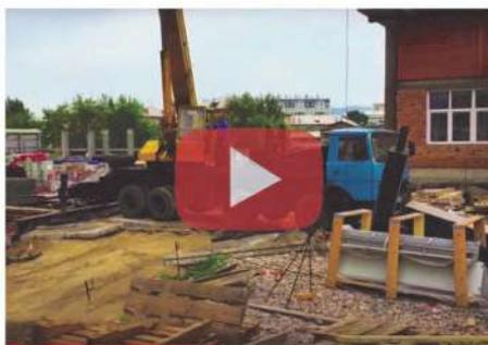
Разбор башенного крана. В работе «Ивановец» 50 тонн
