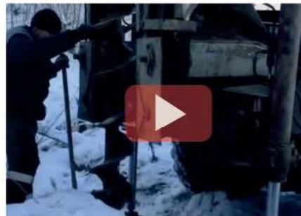
Бурение лунок диаметром 300 мм.
